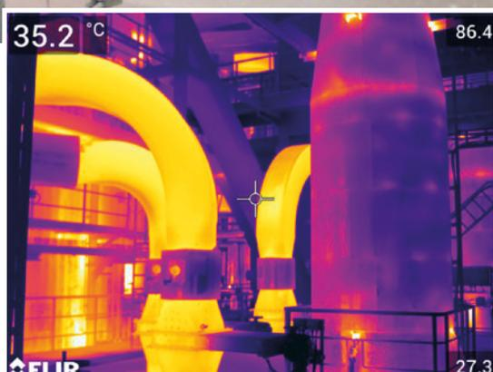
*Rund 10 % der Bauteile in Industrieanlagen, die gedämmt werden können, sind ungedämmt oder ihre Dämmung ist schlecht in Stand gehalten. Die Thermografie-Aufnahme zeigt: Der Wärmeverlust ist in diesen Bereichen erheblich.*
